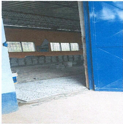
Foto 3: Colocación del piso de granito, del aula módulo 4.
