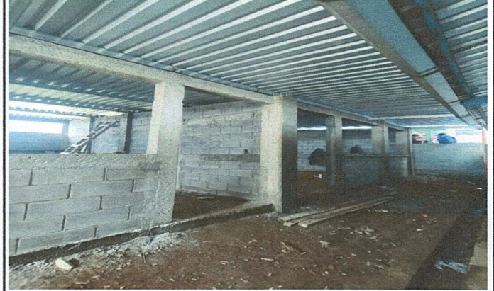
Foto 2: Vista del modulo 6. En proceso de remozamiento
