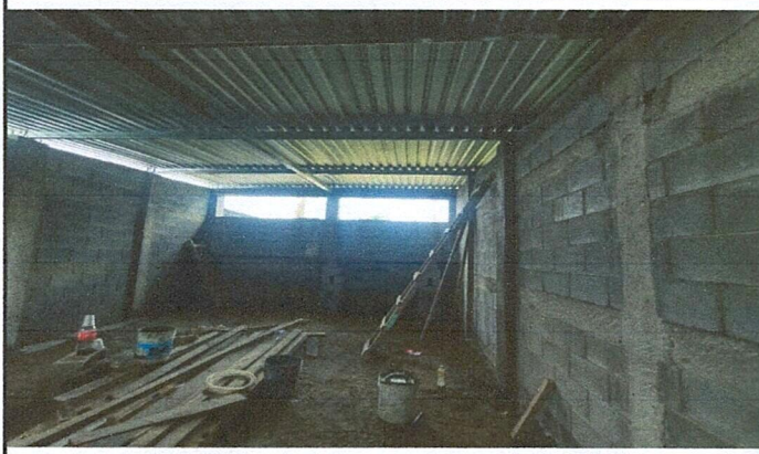
Foto 1: Interior de aulas en proceso de remozamiento.
