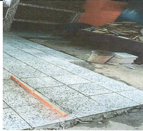
Foto 4: Colocación del piso de granito de la cocina.
